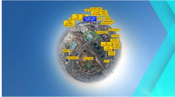
천안시 두정동 건설현장부지 - 항공촬영
